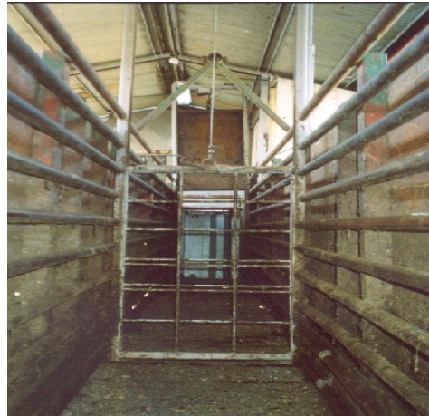
Foto 4: Manga de acceso al cajón de noqueo con puerta de guillotina.
