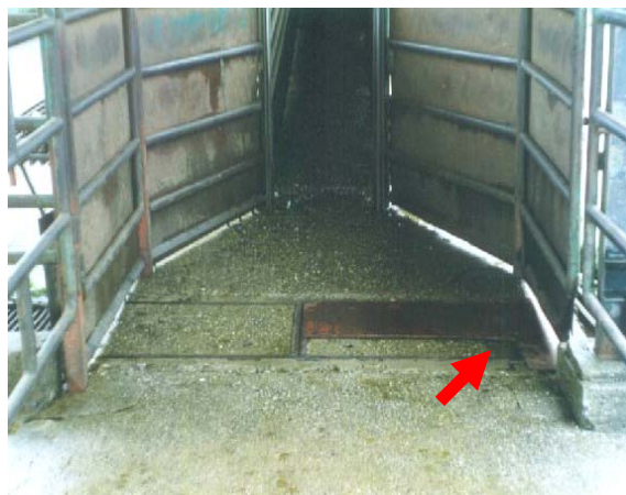
Foto 2: Desagüe cubierto en el pasillo principal de corrales.
