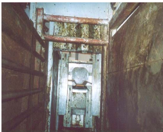
Foto 9: Cajón de noqueo según estructura inicial.
