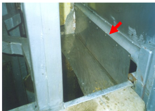
Foto 8: Espacio cubierto sobre la puerta de entrada al cajón de noqueo.
