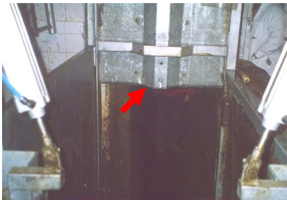
Foto 11: Puerta guillotina del cajón de noqueo según estructura inicial.
