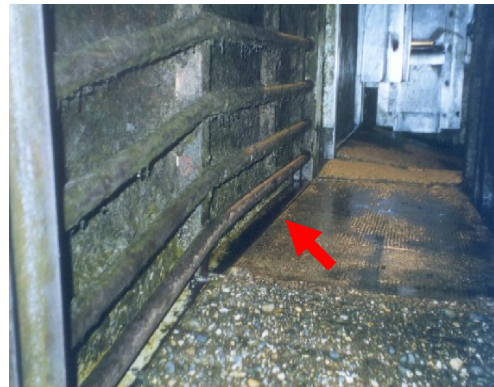
Foto 6: Perfil metálico cubriendo el ángulo entre piso y pared de la manga de acceso al cajón de noqueo.
