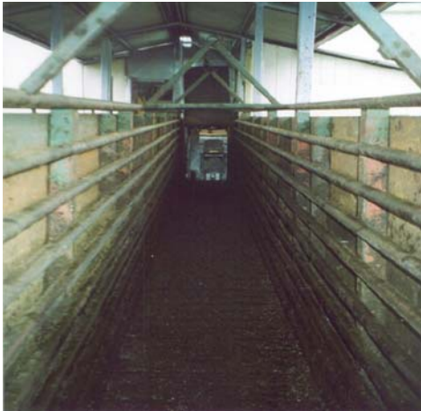
Foto 3: Manga de acceso al cajón de noqueo según estructura inicial.
